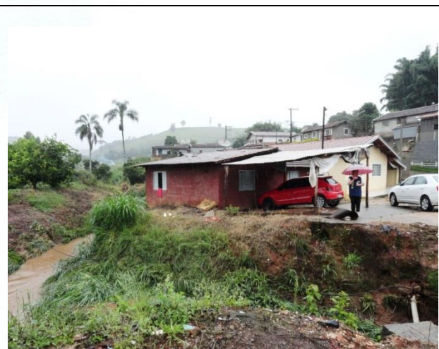
FOTO 4 – Detalhe da moradia atingida, quando da ocorrência de inundações, na margem esquerda do rio do Peixe, ao lado da ponte da Rua Maranhão.
