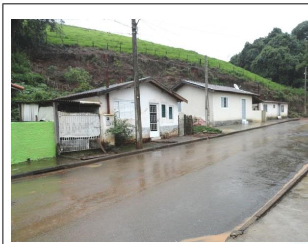
FOTO 17 – Vista geral das moradias na Rua Paraná, onde existe potencial para desenvolver processos de deslizamentos.
