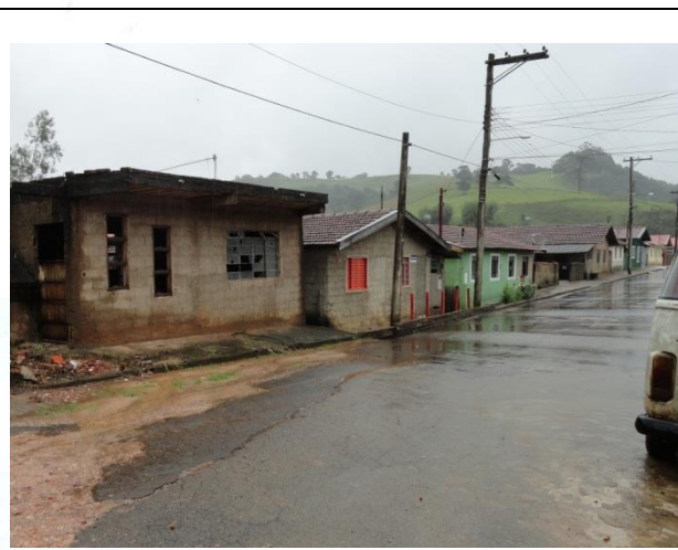
FOTO 6 – Detalhe das casas atingidas no ponto a montante, na Rua Maranhão, na margem direita do rio do Peixe.
