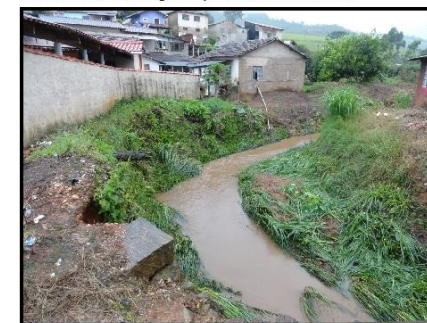
Trecho de inundação do rio do Peixe. Vista da ponte para a área de inundação em direção a montante. Observar a característica meandrante do rio e a proximidade das moradias das margens.
