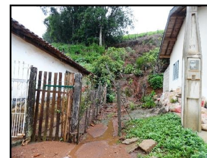
Detalhe do processo erosivo no talude de corte ao fundo de uma das casas.
