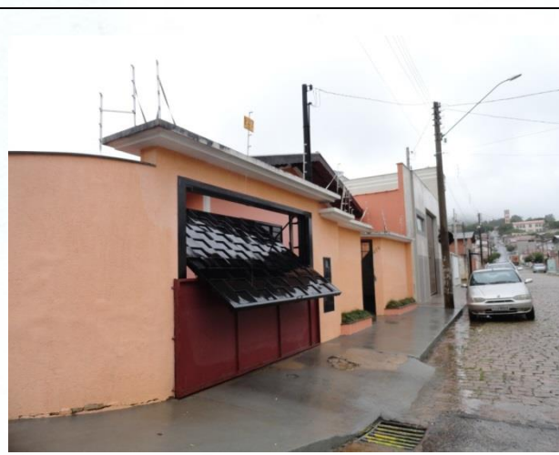
FOTO 12 – Detalhe da moradia na FOTO 11. Observar comporta no portão, para barrar a entrada de água na casa, quando da ocorrência de inundações.
