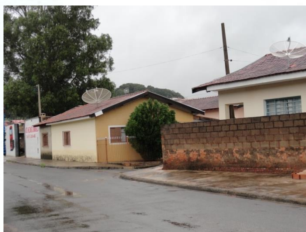
FOTO 16 – Vista geral das moradias na Av. Prefeito Oswaldo Lopes, na altura da Rua Joaquim Pereira de Souza, atingida quando da ocorrência de inundações.
