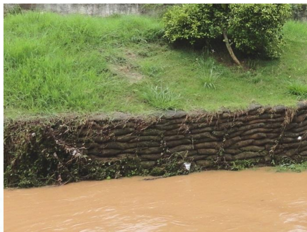
FOTO 14 – Vista do talude marginal do rio do Peixe, com estrutura de contenção feita com solo-cimento ensacado.
