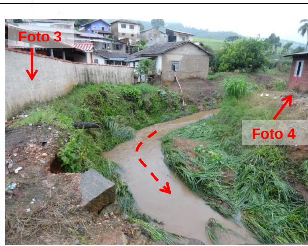
FOTO 2 – Trecho de inundação do rio do Peixe na travessia da Rua Maranhão. Vista da ponte para a área de inundação em direção a montante. Observar a característica meandrante do rio e a proximidade das moradias das margens. As três moradias do lado direito e a moradia do lado esquerdo são inundadas constantemente.
