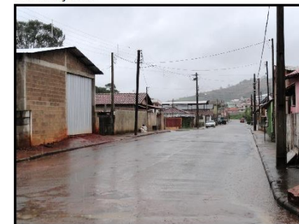
Visão geral do ponto a jusante, na Rua Paraná, atingida quando da ocorrência de inundações.
