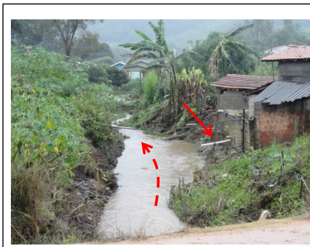
FOTO 1 – Trecho de inundação do rio do Peixe na travessia da Rua Maranhão. Vista da ponte para a área de inundação em direção a jusante. Observar o lançamento de água servida das casas no rio do Peixe.
