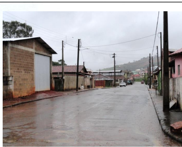
FOTO 8 – Visão geral do ponto a jusante, na Rua Paraná, atingida quando da ocorrência de inundações.
