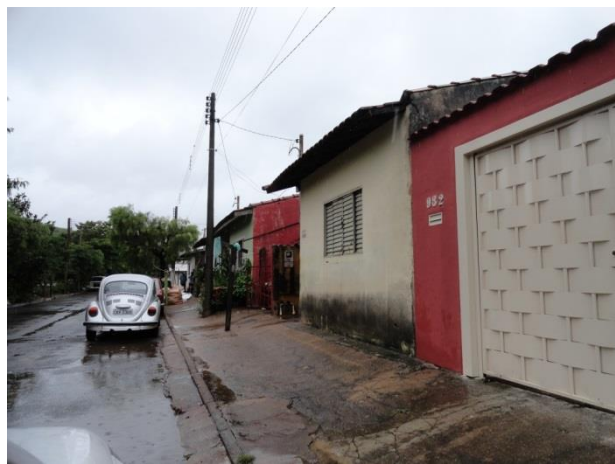
FOTO 13 – Vista geral das moradias na Av. Prefeito Oswaldo Lopes, na altura da Rua Joaquim Garcia, atingida, quando da ocorrência de inundações.
