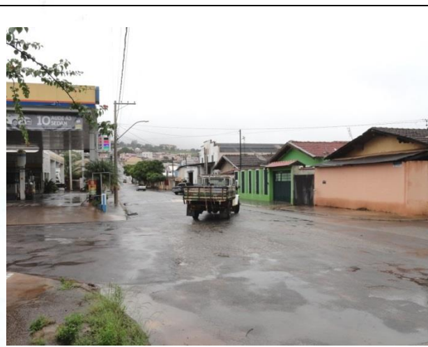
FOTO 10 – Vista geral da Rua Barão do Rio Branco, transversal à Av. Prefeito Oswaldo Lopes, atingida quando da ocorrência de inundações.
