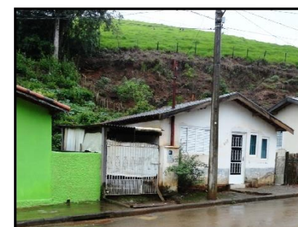
Detalhe de uma das moradias e do talude de corte.
