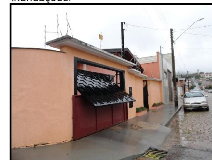
Detalhe da moradia. Observar comporta no portão, para barrar a entrada de água na casa, quando da ocorrência de inundações.
