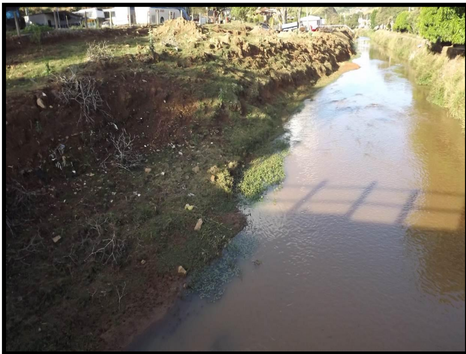
Imagem 51 - Solapamento de barranco do Rio do Peixe
