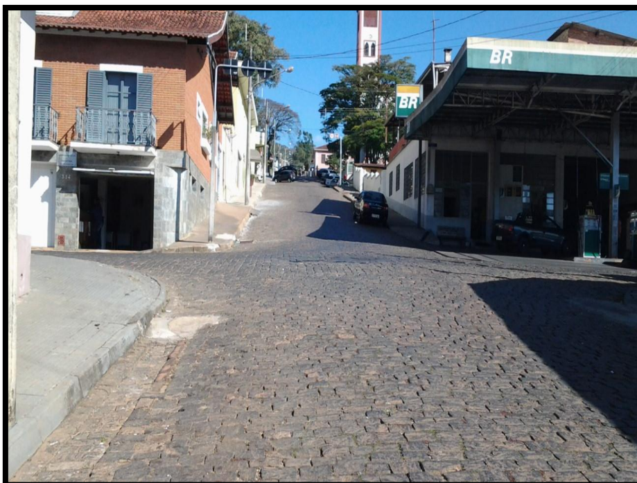
Imagem 53 - Ponto de Alagamento
