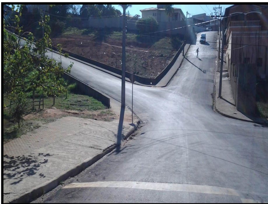
Imagem 60 - Ponto de Alagamento
