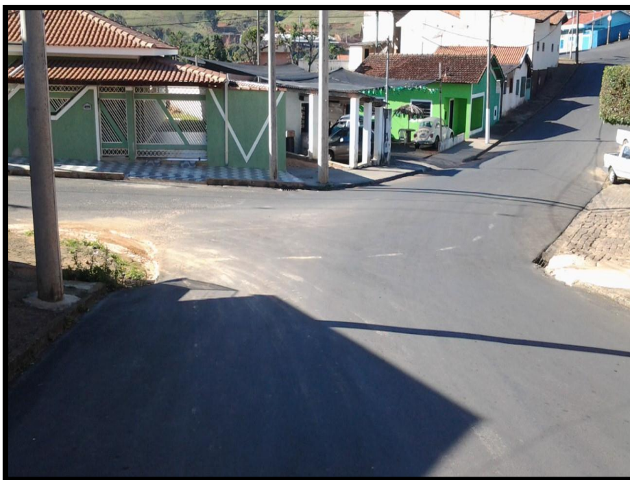
Imagem 61 - Ponto de Alagamento - Rua Goiás
