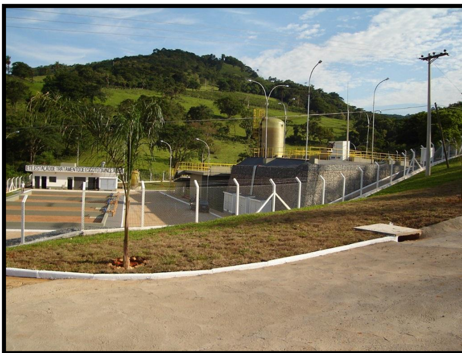
Imagem 17 - Vista da ETE
