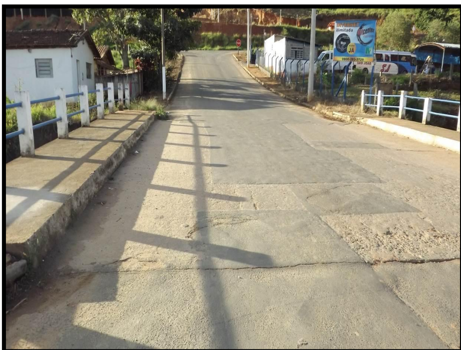
Imagem 52 - Ponte sobre o Rio do Peixe
