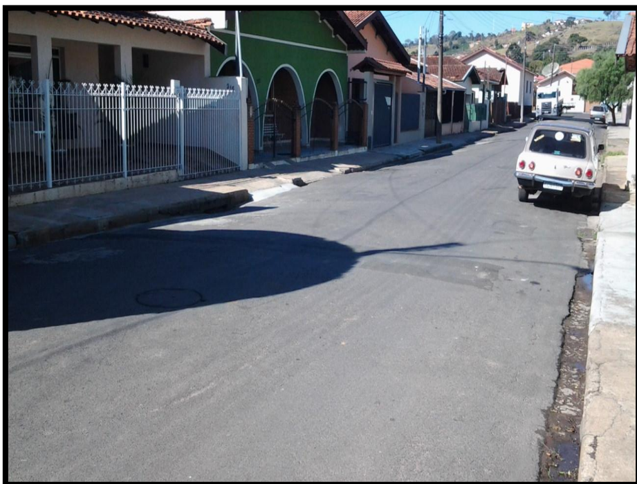
Imagem 58 - Ponto de Alagamento
