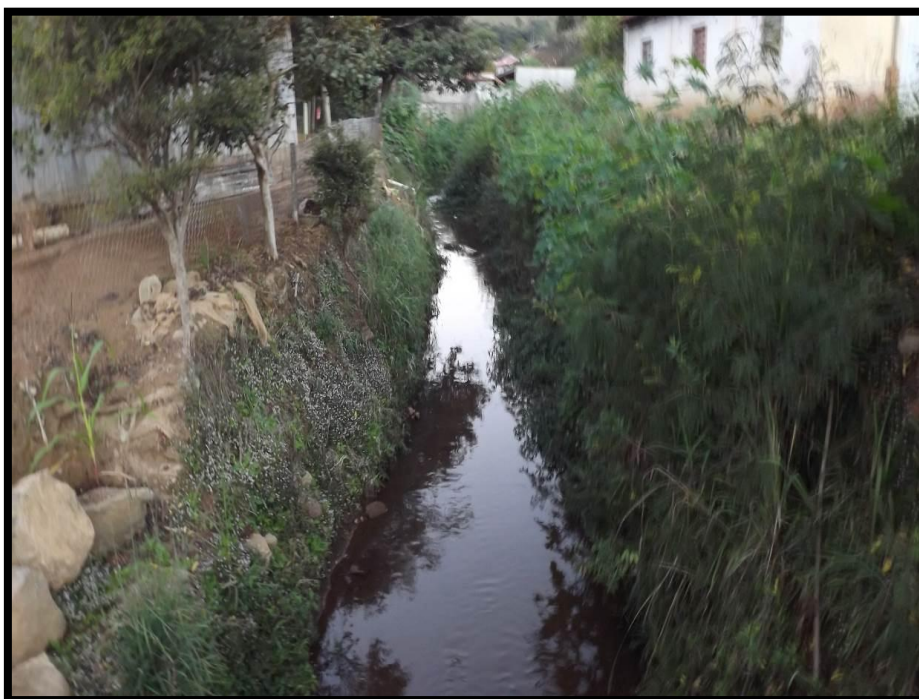
Imagem 68 - Risco de desmoronamento – Afluente do Rio do Peixe
